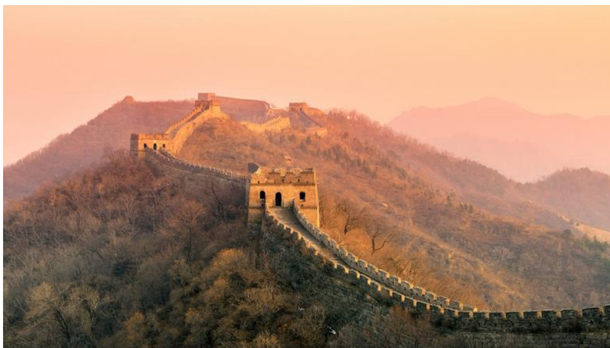
Chinesische Mauer. Baubeginn ca. 7. Jahrhundert vor Christus, Gesamtlänge ca. 21.196 Kilometer
